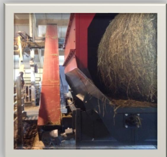
Skruer tar her fôret opp på utfôringsband
